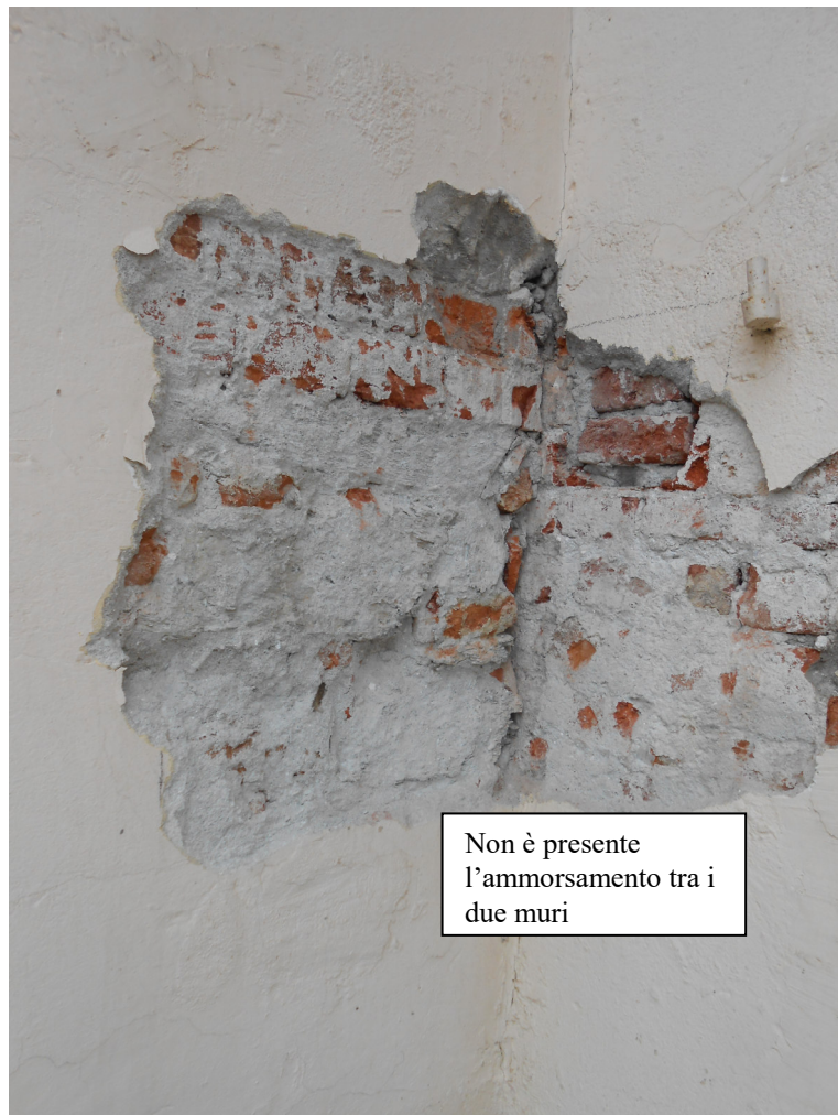
Sondaggio; rimozione intonaco tra i due edifici in adiacenza
