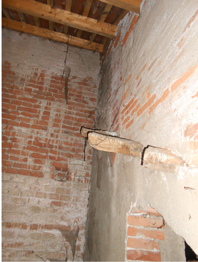
Verifica ammorsamento muri tra i due edifici della Scuola
