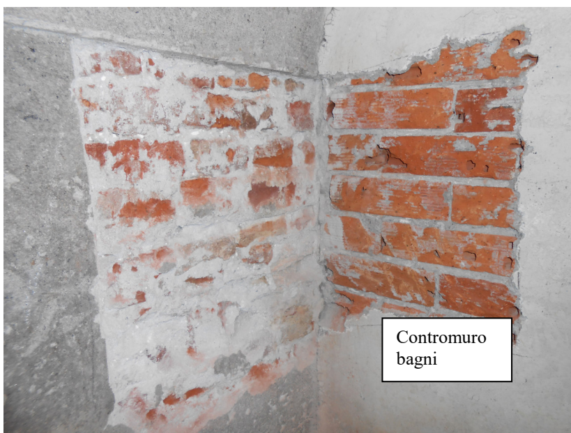
Sondaggio; rimozione intonaco al piano terra
