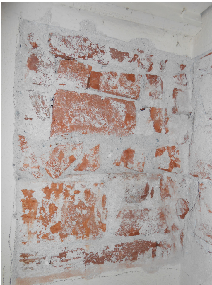
Sondaggio; rimozione intonaco al piano primo
